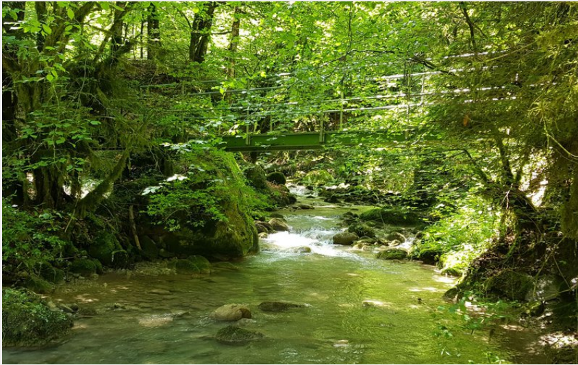
Passerelle du Laudon, visible en fin de parcours (© A.Mollard / PNRMB)
